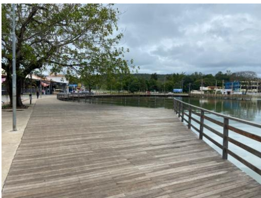
Figura 7- Revitalização do deck- situação atual
