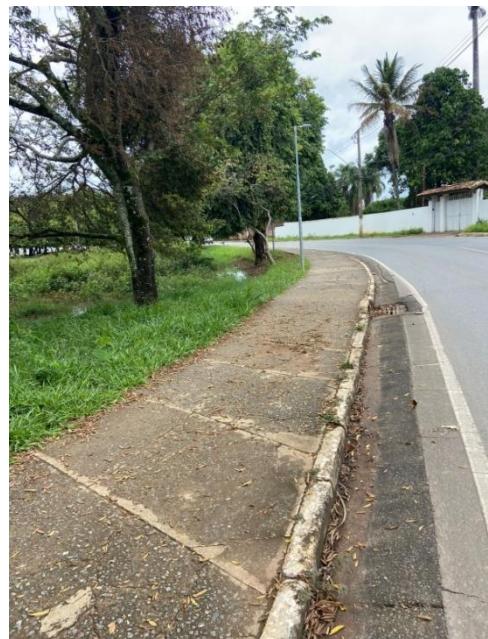
Figura 2- Parte do passeio da Orla que será revitalizado.
