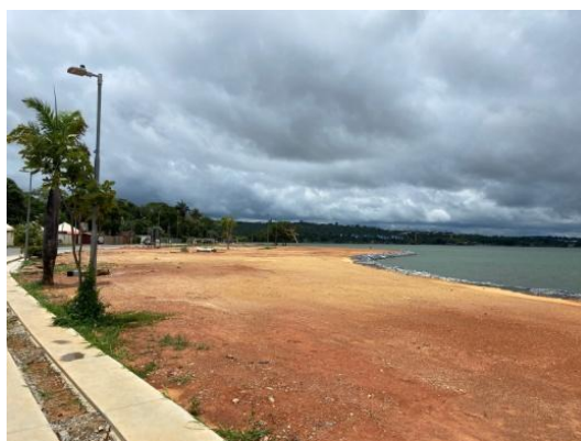
Figura 8- Segunda etapa da reforma do Areião- Situação atual.
