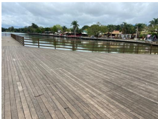
Figura 6- Revitalização do deck- situação atual
