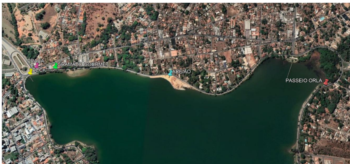
Figura 1- Vista superior do local de implantação do objeto do contrato em questão.
