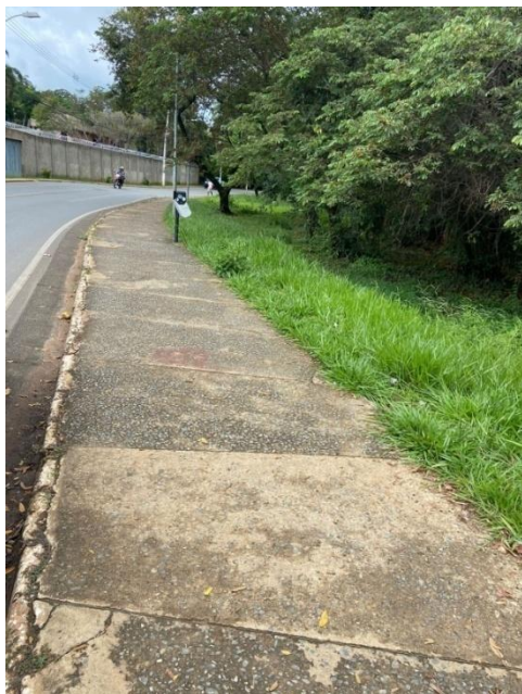
Figura 2- Parte do passeio da Orla que será revitalizado.
